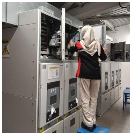
Gambar 6, Pengambilan Data Energi Listrik (kWh Ekspor) di MV Room
